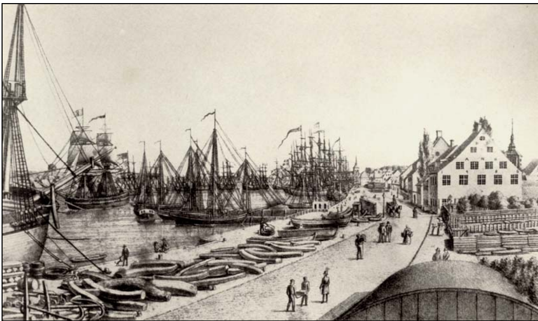
Schiffbrücke in Flensburg 1833
